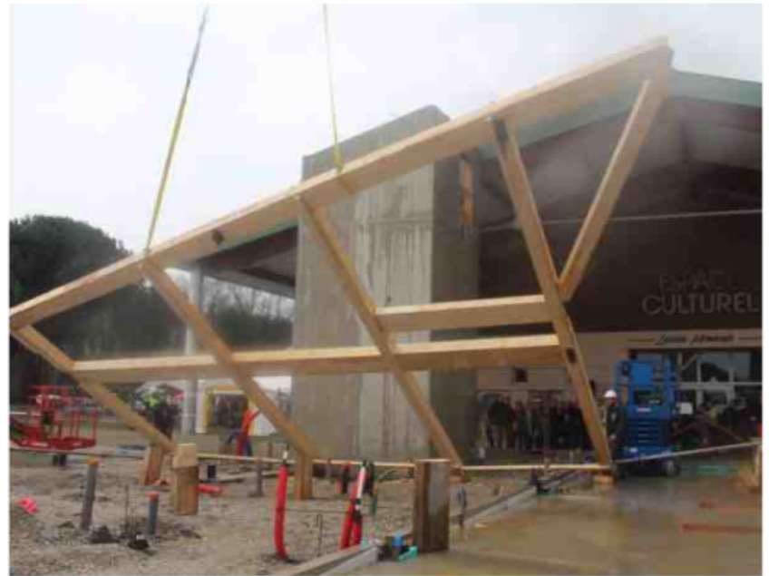
La levée de la charpente du Chahut. J.-P. D.
